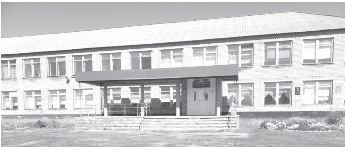
В Яшкинской школе завершается ремонт.
